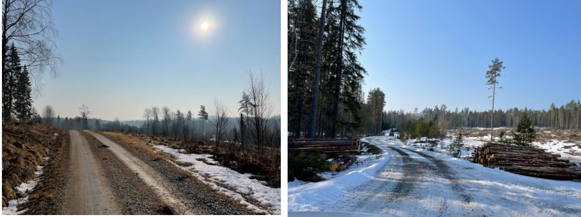
Figur 8. Befintliga vägar från i projektområdet. Vägarna kommer behöva förstärkas och breddas samt rätas ut. Vid sidan av vägen kommer kabelgraven för det interna elnätet förläggas. Till vänster Styggjtjärnsvägen och till höger bild från Flytsberget.
