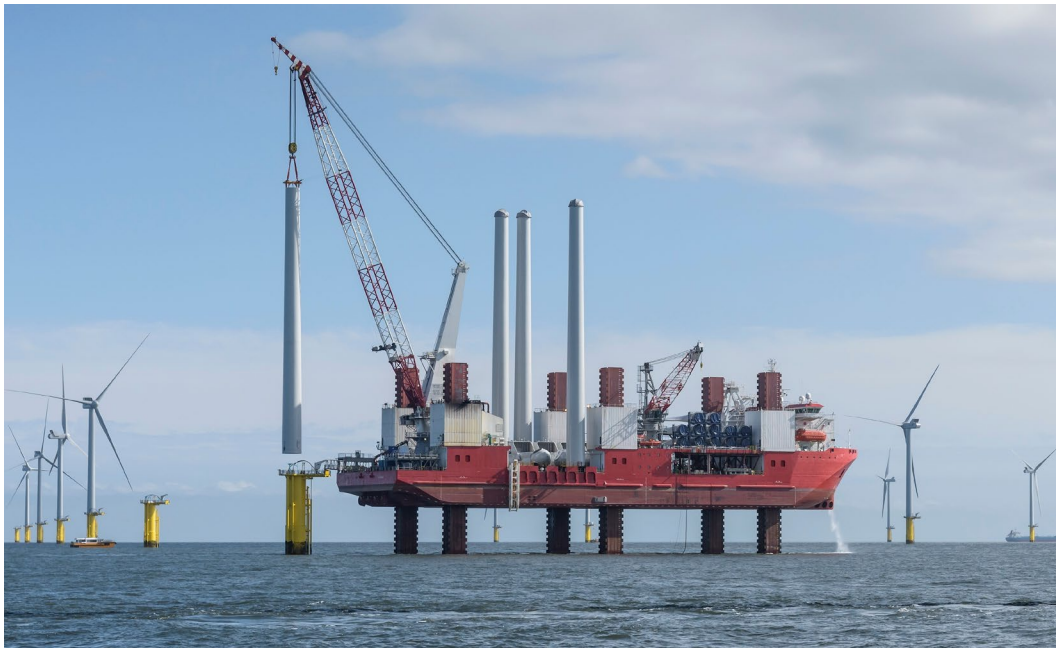
Figur 33. Anläggning av vindkraftverk med jack-up fartyg
