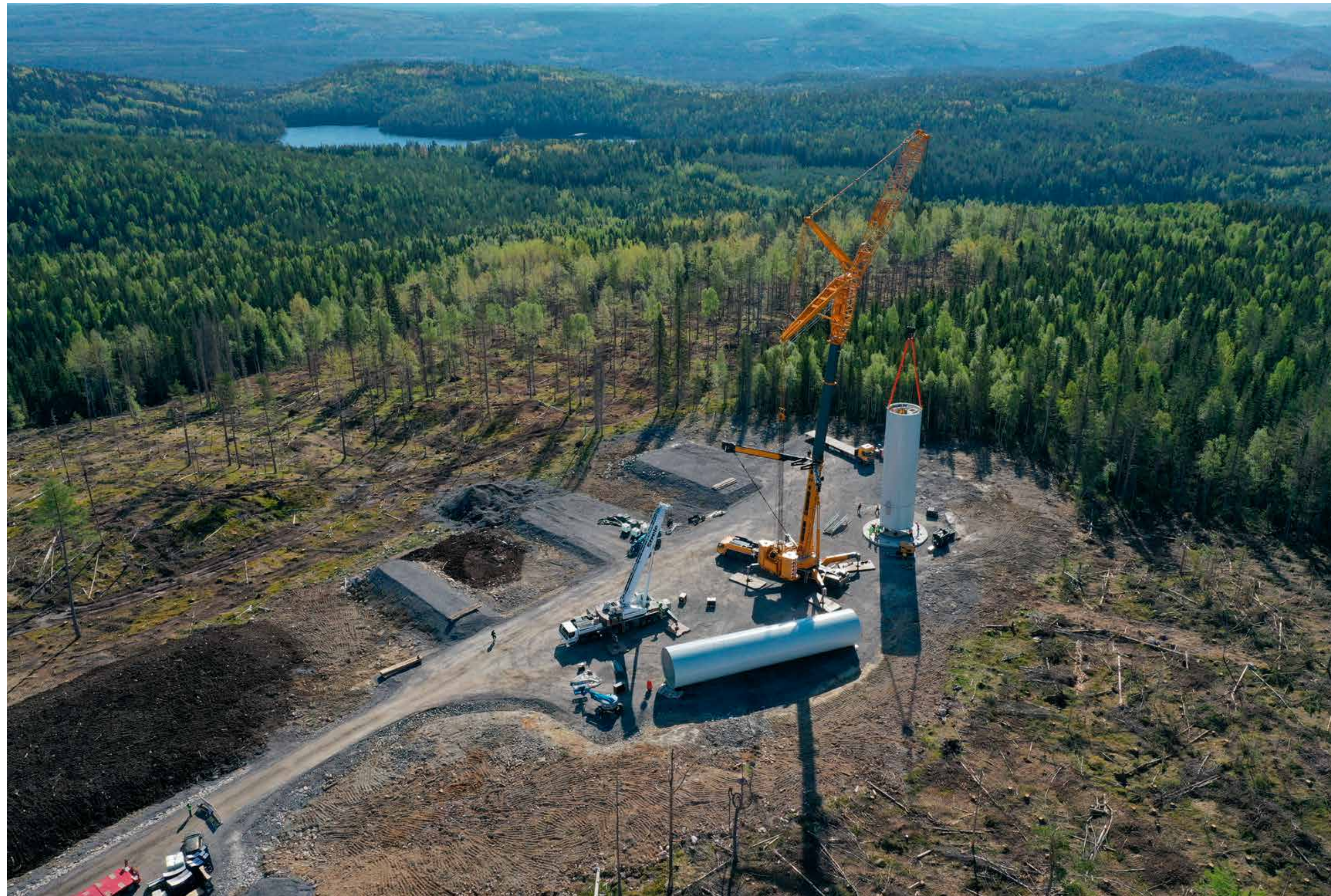
Byggnation av vindkraftspark Stor-Skälsjön i Sundsvall.
