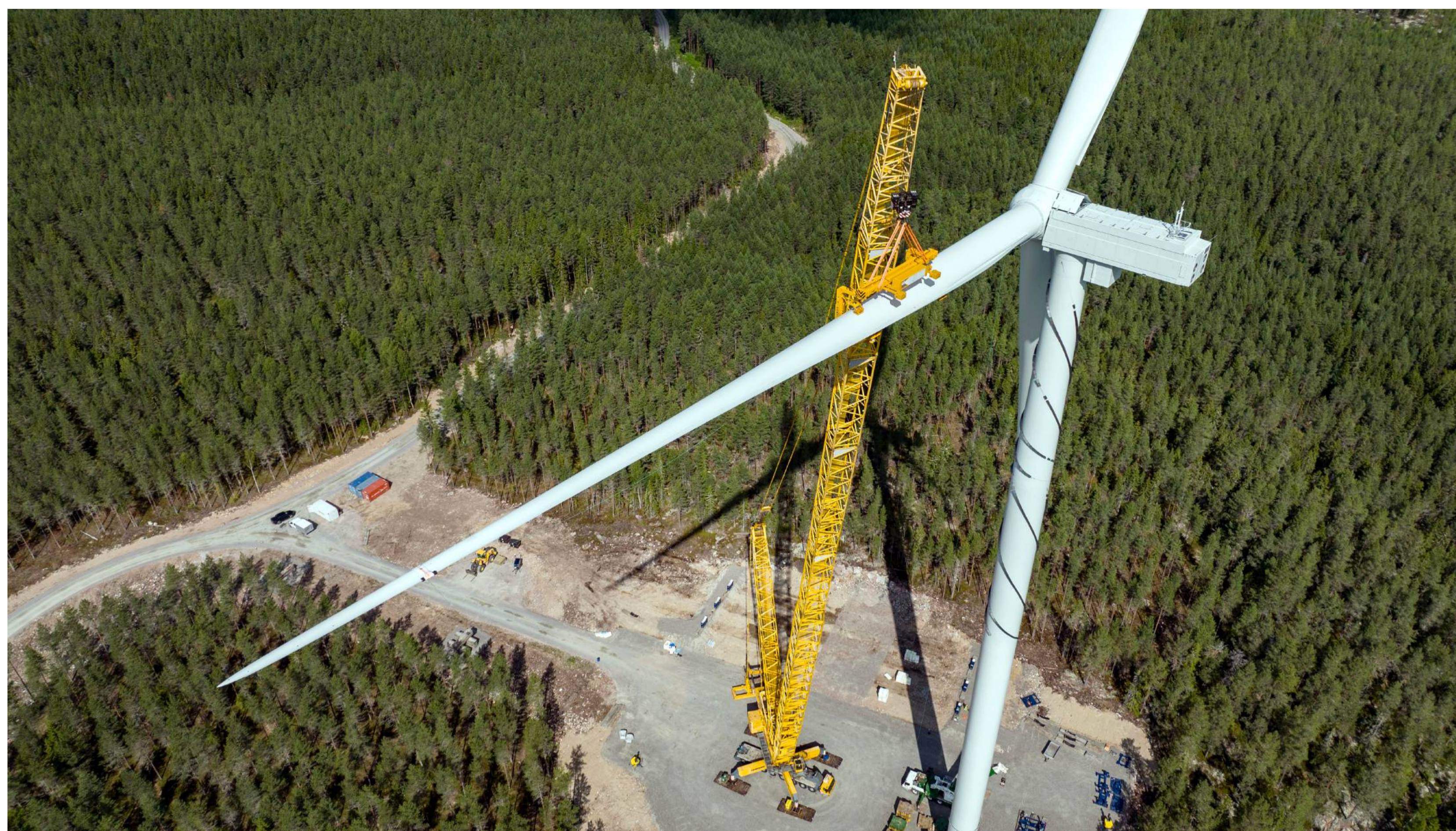
Byggnation av vindkraftspark Tjärnäs i Hedemora.
